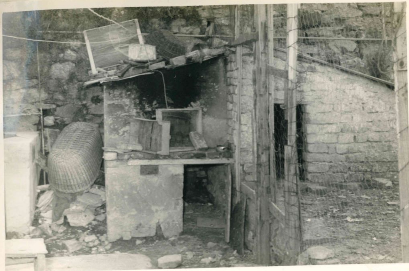
Ingresso al corridoio sito nella parte posteriore della casa formato dal muro perimetrale e il terrapieno.
